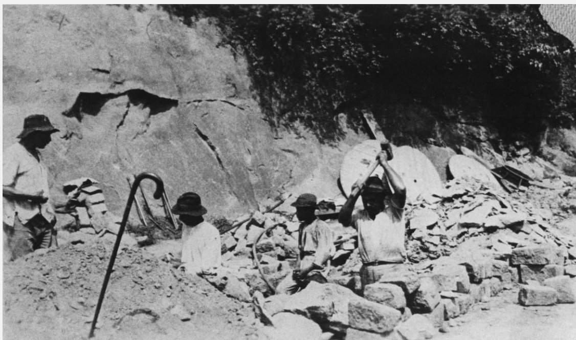
Fotografia 6 – “Corte de pedras para a caixa de emendas”.
