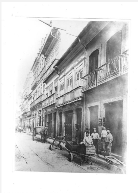
Fotografia 4 – “Carregadores e casas marcadas para desapropriação”.
