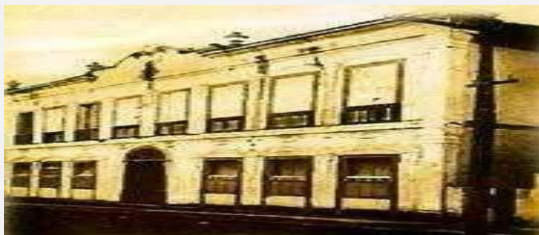
Imagem 3: Edifício do Liceu Triângulo Mineiro (1941), situado na rua Cel. Manoel Borges, 56. Fonte: Acervo Mário Palmério
