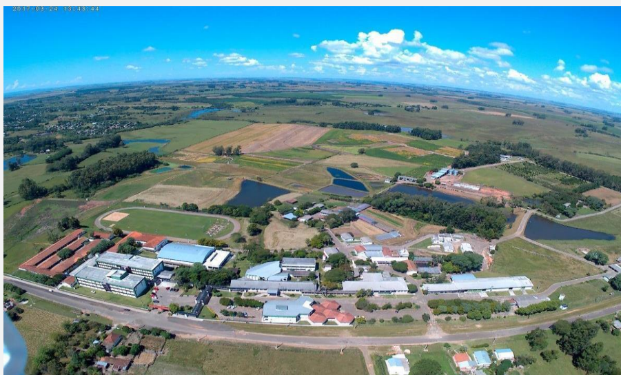
Fotografia 1 - Sede do IFFar - SVS visão aérea. Fonte: Autoria do servidor Denis Pohlmann Gonçalves.
