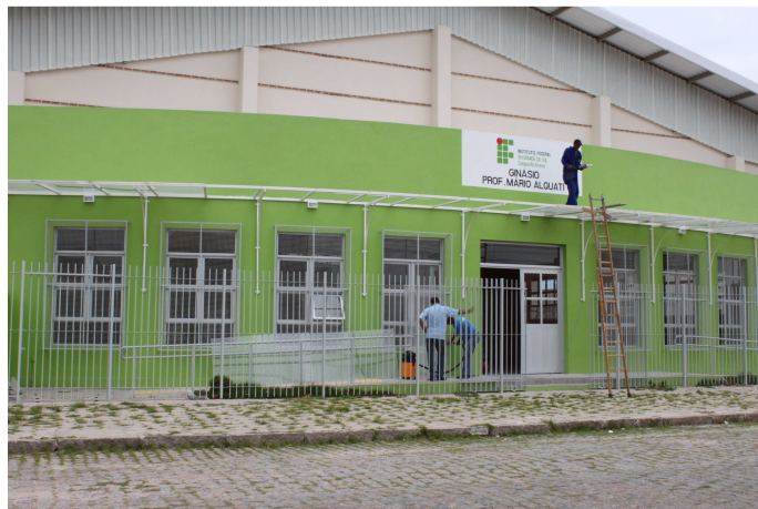
Ajustes finais na fachada do ginásio.
