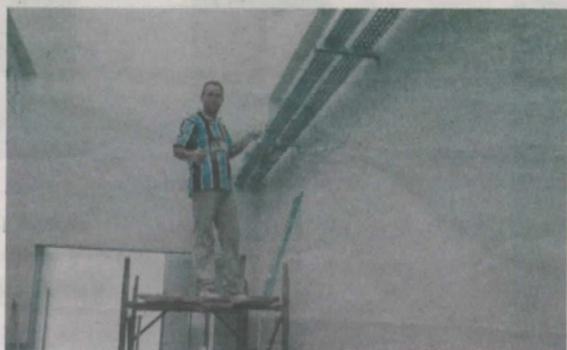
Funcionários trabalham a pleno vapor para entregar a obra
