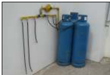
Instalação de gás para aquecimento
