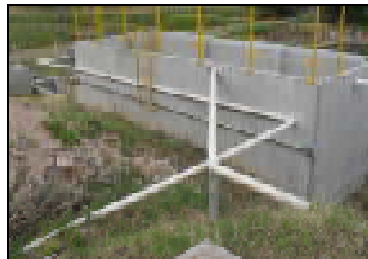
Conclusão da Estação de tratamento de efluentes (ETE)
