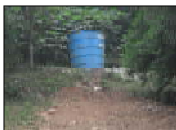
Reservatório de água
